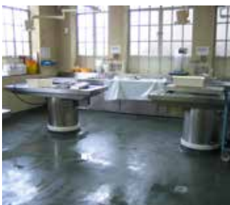
Piso de hormigón antes de la aplicación
