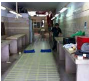
Piso de baldosas antes de la aplicación
