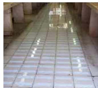
Piso de baldosas después de la aplicación
