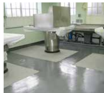
Piso de hormigón después de la aplicación
